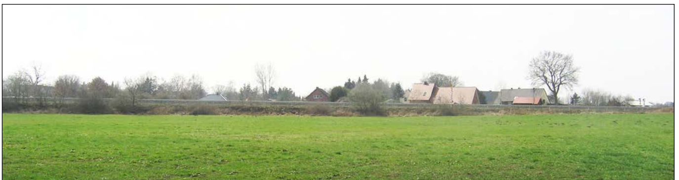
Blick in südliche Richtung mit dem Bahndamm und dem Siedlungsrand von Wehdel dahinter
