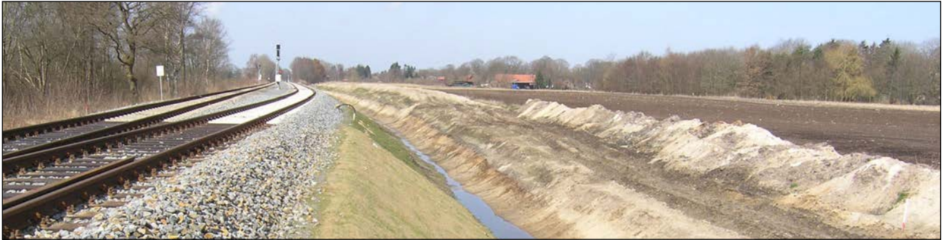
Westlicher Teilbereich / Blick in westliche Richtung / Bahndamm mit neuem Ausweichgleis
