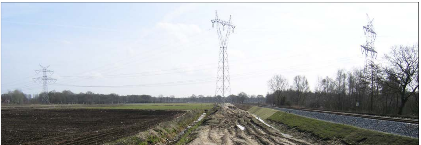
Östlicher Teilbereich / Blick in östliche Richtung
