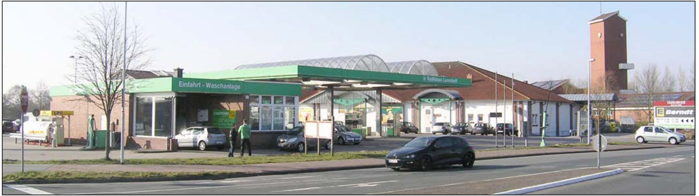
Südöstliche Ecke des Geltungsbereiches (Zum Feldkamp) mit Waschanlage, Edeka-Markt / Feuerwehrgebäude im Hintergrund
