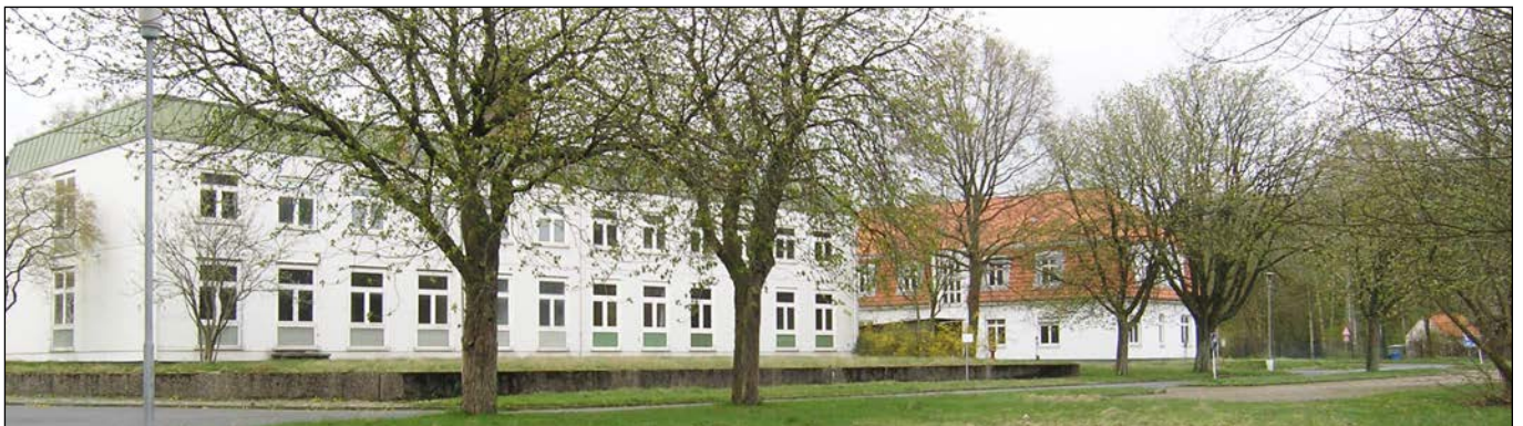
Südöstliche Ansicht des Gebäudeensembles
