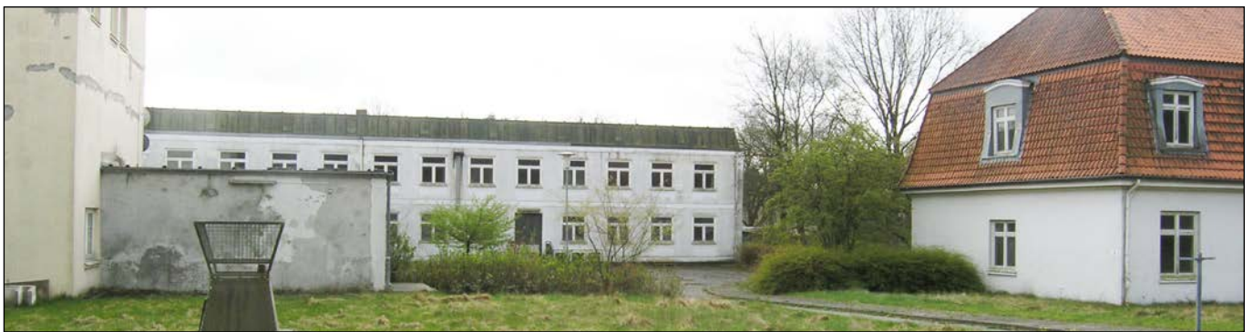
Rückseiten des Gebäudeensembles im Nordwesten
