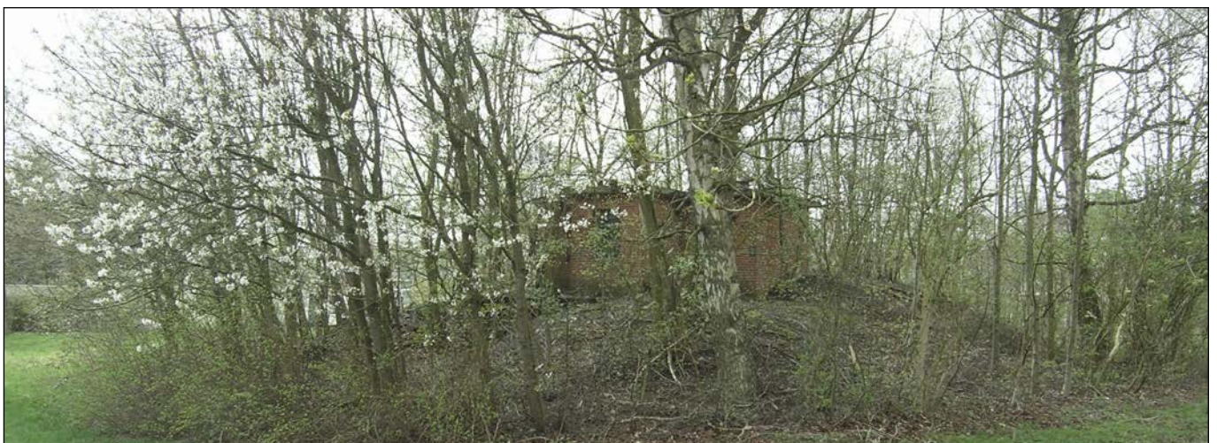
Reinwasserbehälter an der Hauptzufahrt
