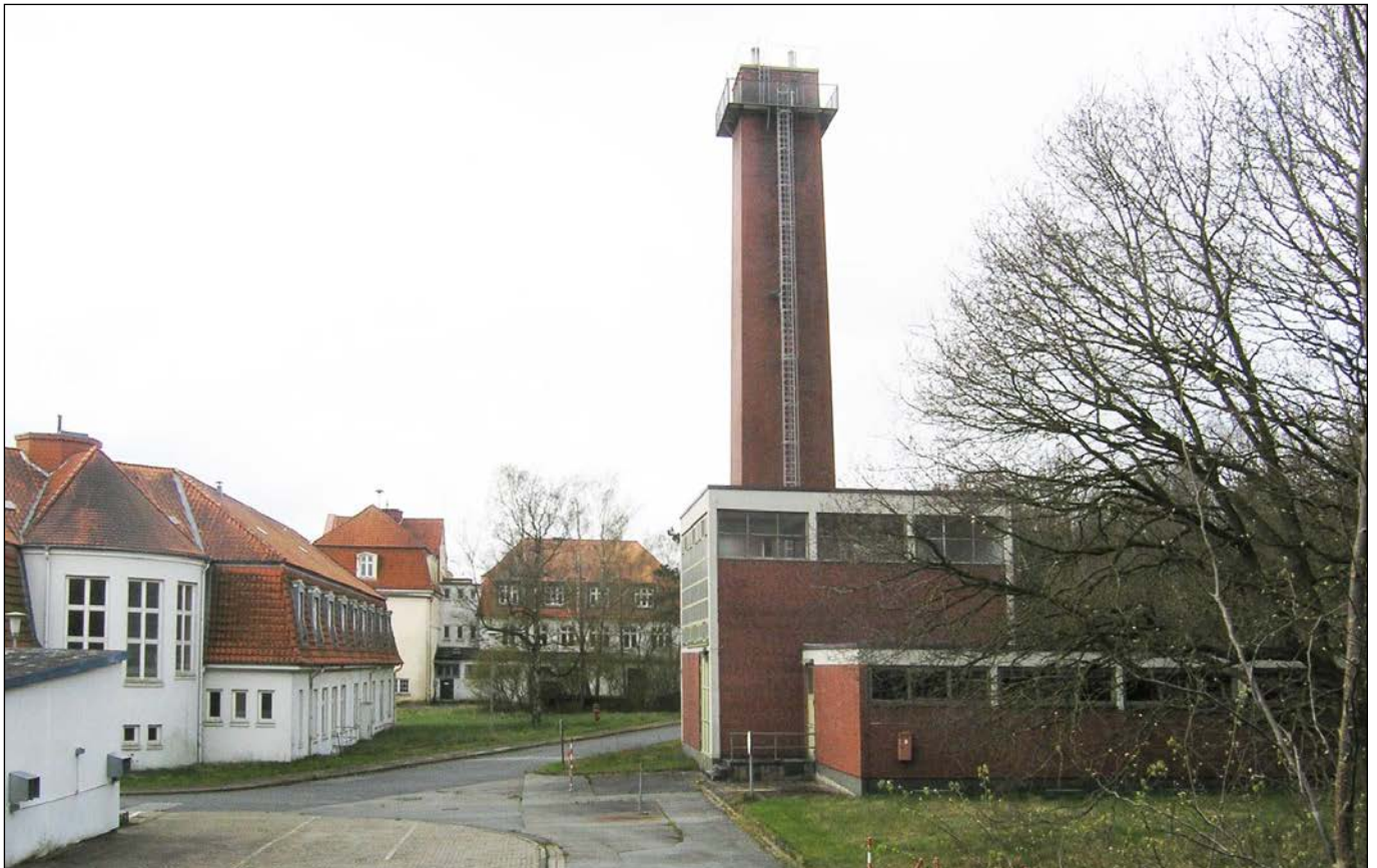
Nordöstlicher Teilbereich mit der Heizzentrale
