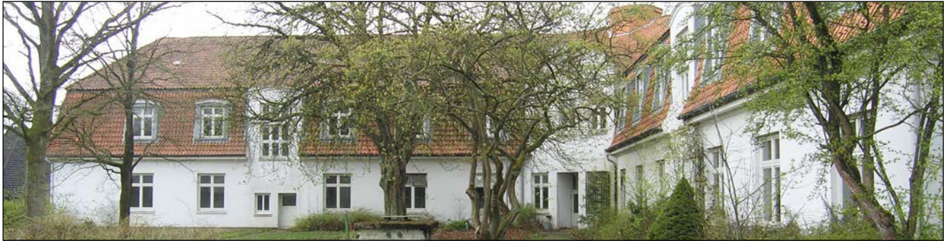
Westlicher Flügelbau des Gebäudeensembles
