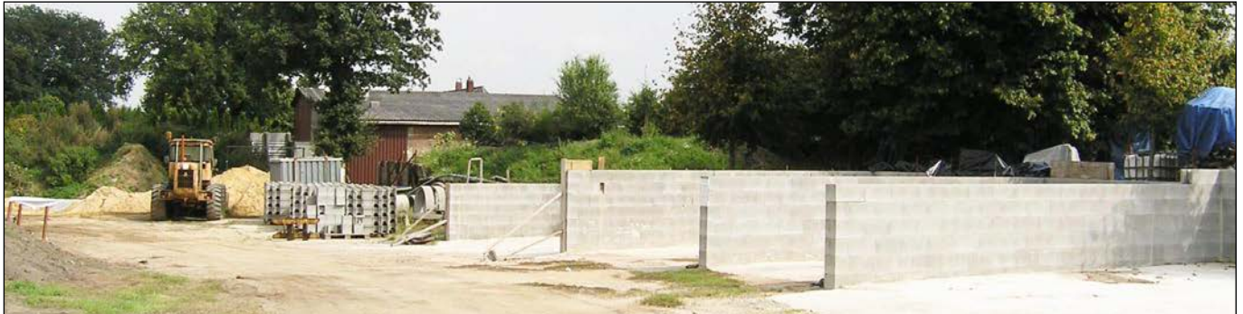
Lagerboxen an der Grundstücksgrenze im Südosten
