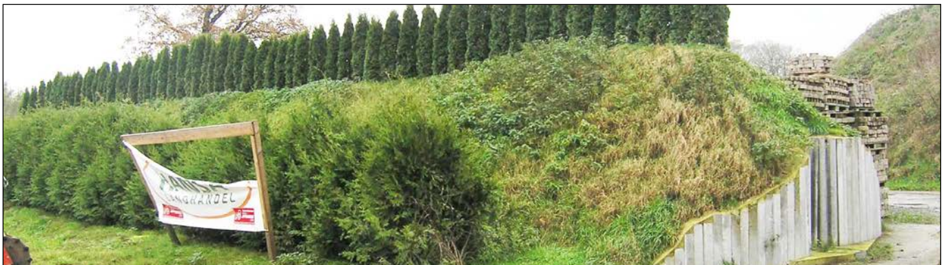
Lärm./Sichtschutzwall neben der neuen Zufahrt
