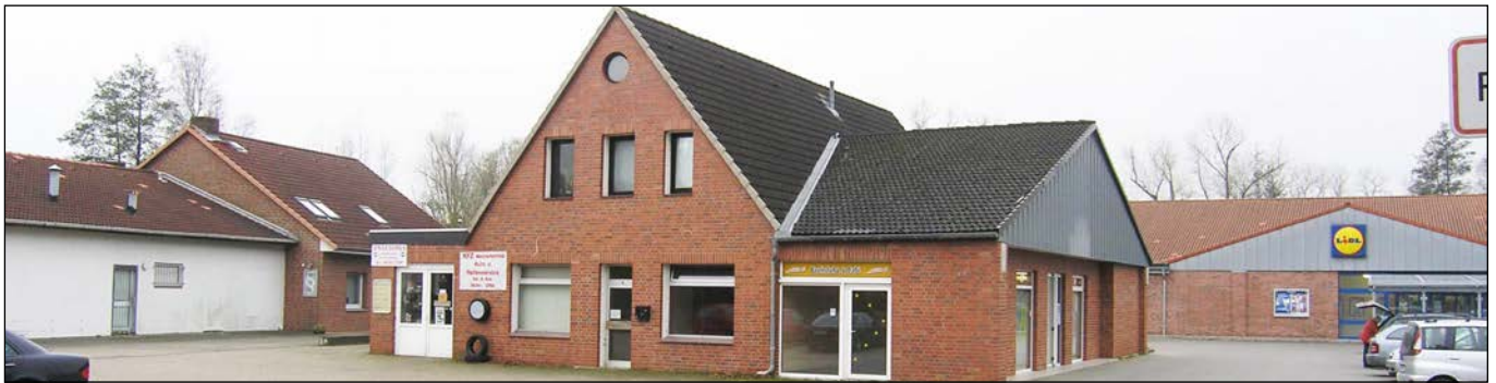
Das zum Abriss vorgesehene Gebäude
