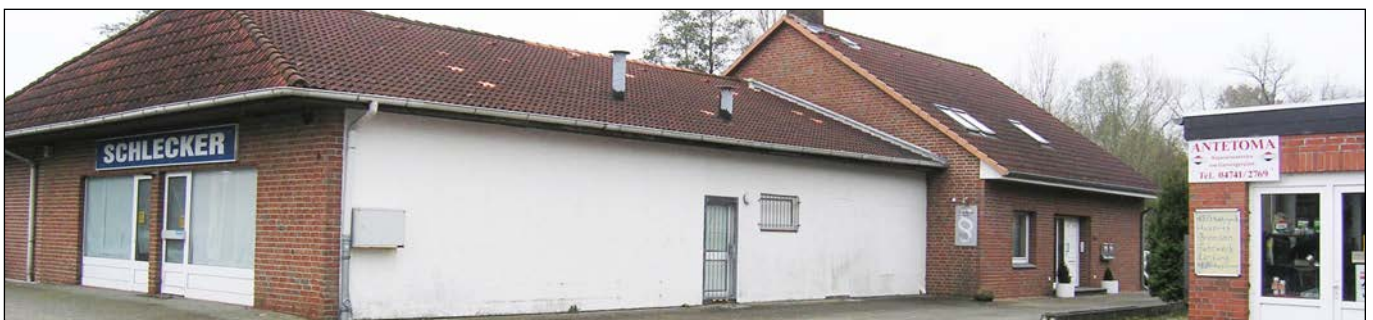
Wohnhaus Oderstraße 6 a mit gewerblichem Anbau (Blick von Nordwesten)
