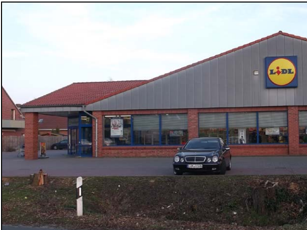
Gebäude Lidl-Markt von Westen
