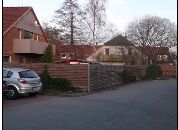
Schallschutzwand Bereich Oderstraße 6a
