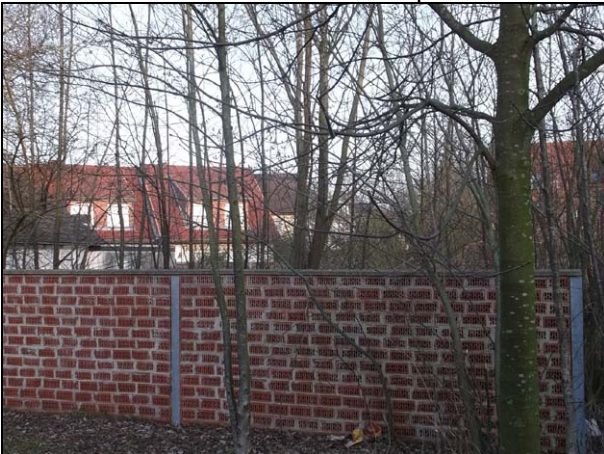
Schallschutzwand östlich Pkw-Stellplätze 51-54
