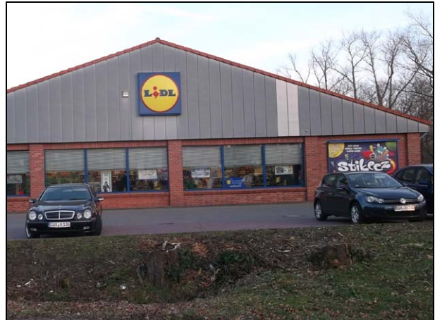
Gebäude Lidl-Markt von Westen
