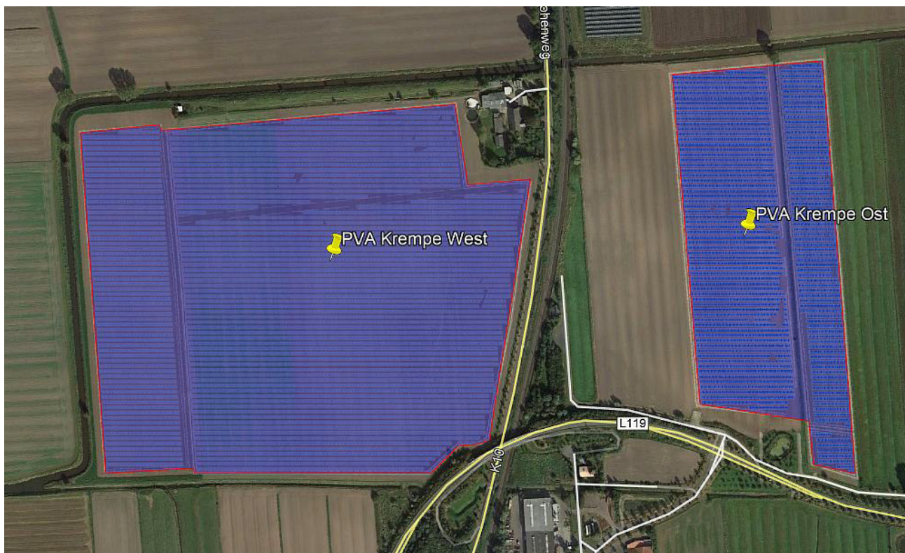
Bild 2.1.2: Detailansicht der PV Flächen (Quelle: Google Earth/SolPEG)
